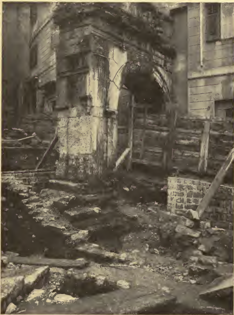
FIG. 3. — Trieste. Lavori d'isolamento dell'arco.
