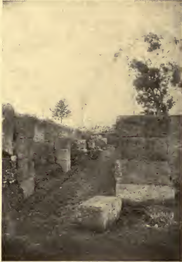
FIG. 3. — Edificio a pilastri di tufo.
