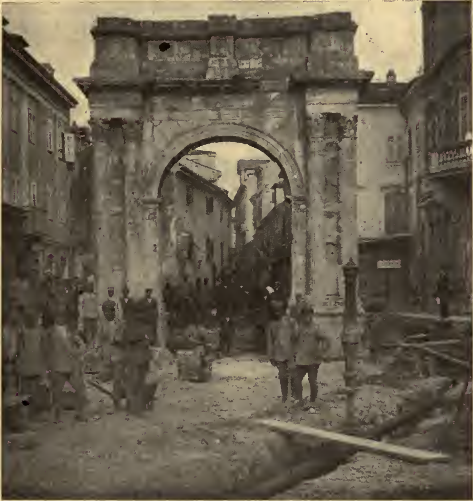
L'Arco di Sergi durante i lavori di liberazione.
